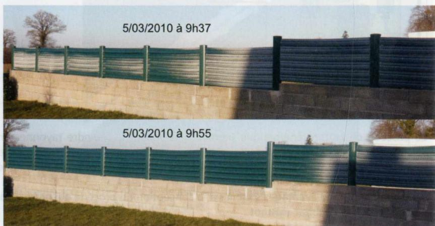
Figure 52 - Dégivrage naturel de la clôture énergétique.
