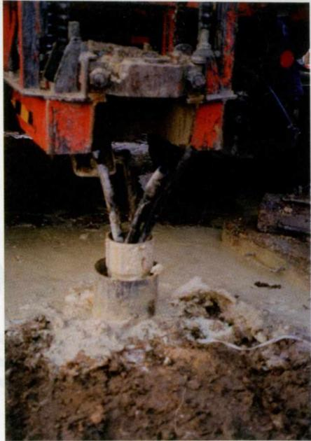
Figure 131 - Sonde géothermique sur forage vertical.
