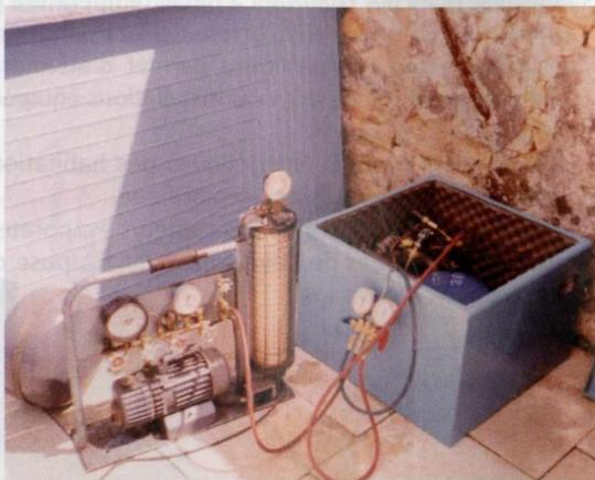
Figure 85 - Remplissage en gaz d'une PAC installée à l'extérieur
