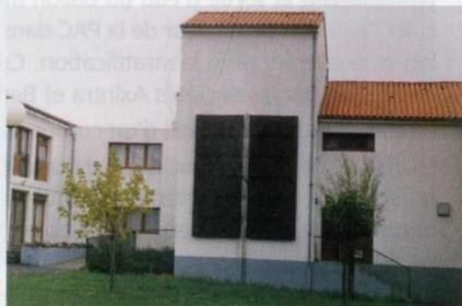
Figure 116 - Capteurs évaporateurs d'un chauffe-eau de 3 000 litres (doc. Axergie).
