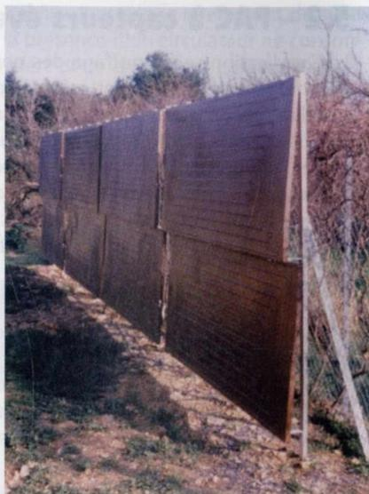
Figure 76 - Exemple de fixation des capteurs sur poteaux (Doc. Axergie).
