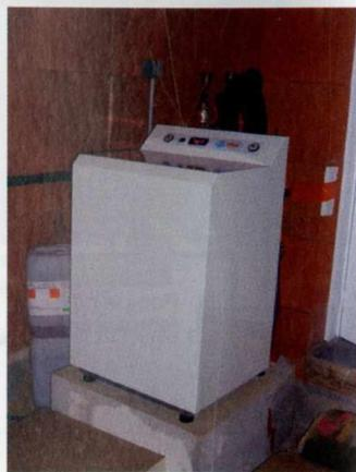
Figure 67 - PAC de 7,1 kW sur clôture énergétique.
