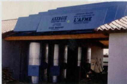
Figure 115 - Chauffe-eau aérosoleaire de grande capacité (camping) (doc. Axergie).
