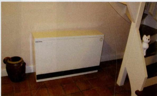
Figure 127 - Radiateur électrique à accumulation.
