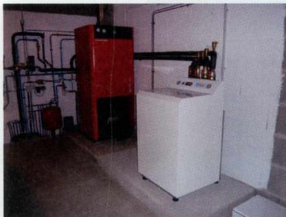
Figure 69 - PAC de 12 kW sur clôture dans l'existant.
