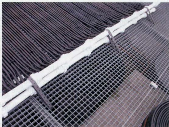
Figure 50 - Mise en œuvre sur caillebotis.
