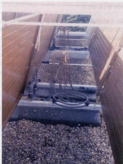
Figure 75 - Exemple de pose en toiture-terrasse avec vue des boucles d'alimentation 1/4" (Doc. Axergie).
