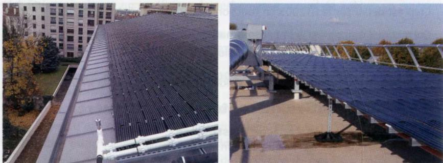
Figure 49 - Pose sur châssis.
