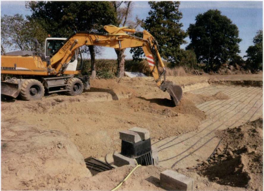
Figure 120 - Étrelles (35) : capteur enterré de 800 m sur 200 m<sup>2</sup> (doc. Bernier Energies).
