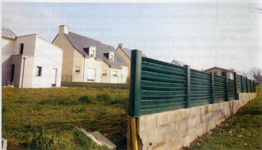
Figure 68 - Clôture énergétique de 18 m à Vitré (Doc. Bernier Energies).
