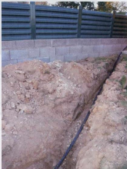
Figure 61 - Tube enterré d'alimentation de la clôture.
