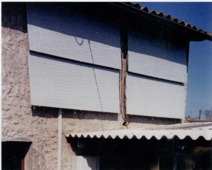
Figure 90 - Installation des capteurs sur un mur de maison (Doc. Axergie)
