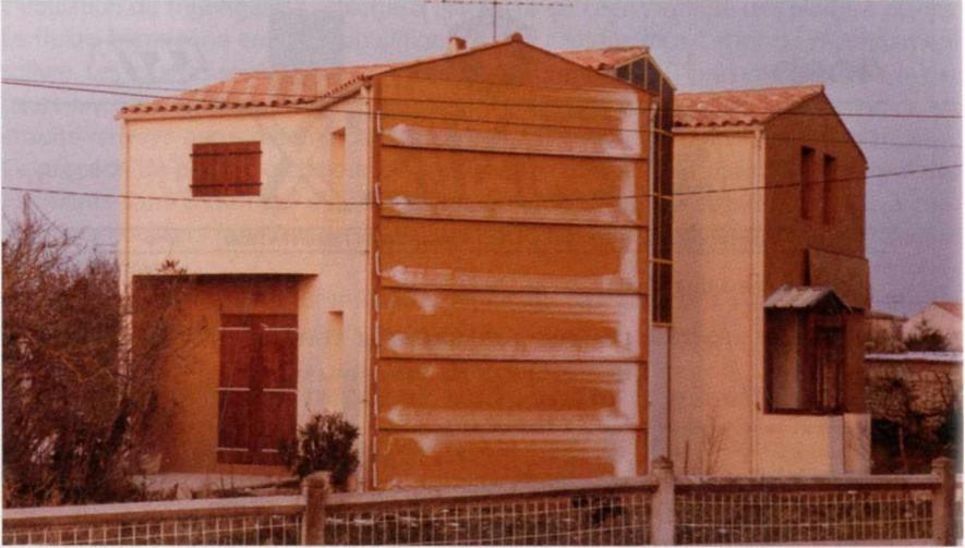
Figure 29 - Capteurs évaporateurs Angoulins 1984 (Doc. Axergie)
