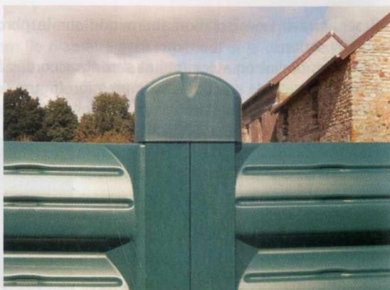
Figure 64 - Pose des capots de protection.
