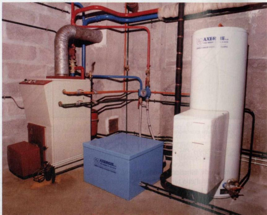
Figure 88 - Installation de la PAC en alternatif asservi (Doc. Axergie).
