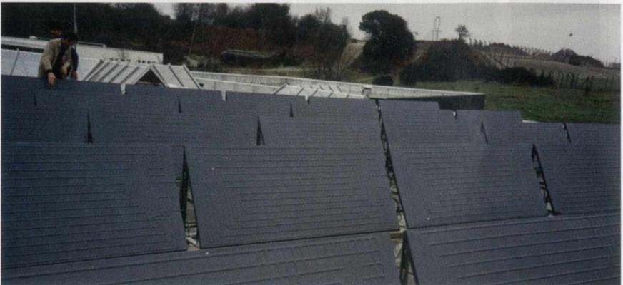
Figure 81 - Montage en terrasse des capteurs (Doc. Axergie).
