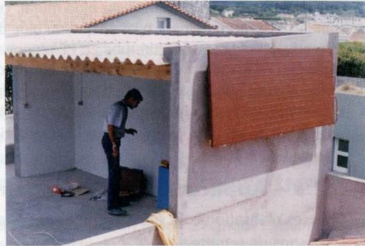
Figure 113 - Capteur évaporateur de ballon aérosolaire.
